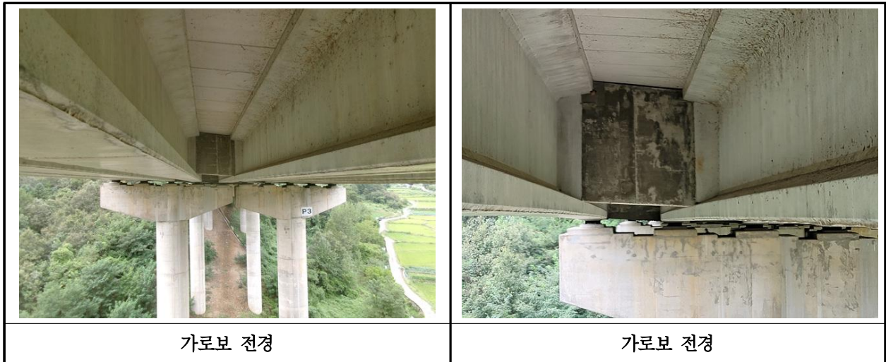
【사진 12.3.31】 가로보 전경
