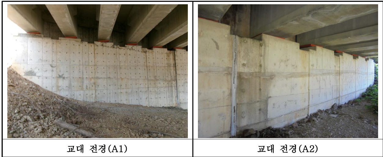
【사진 12.3.33】 교대 전경
