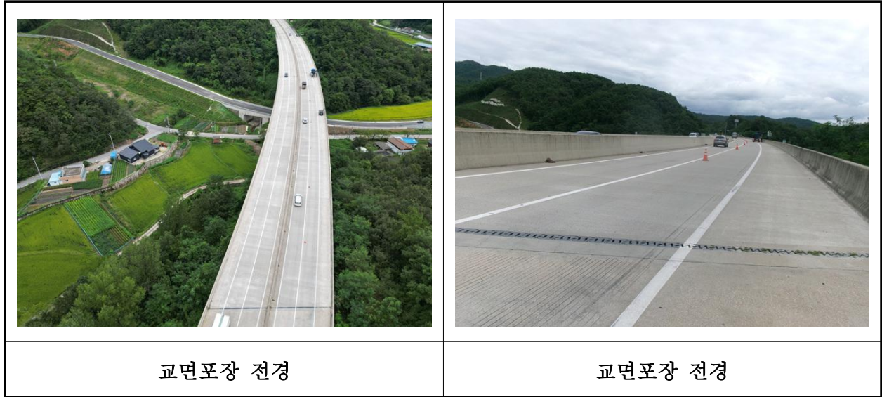
【사진 12.3.45】 교면포장 전경
