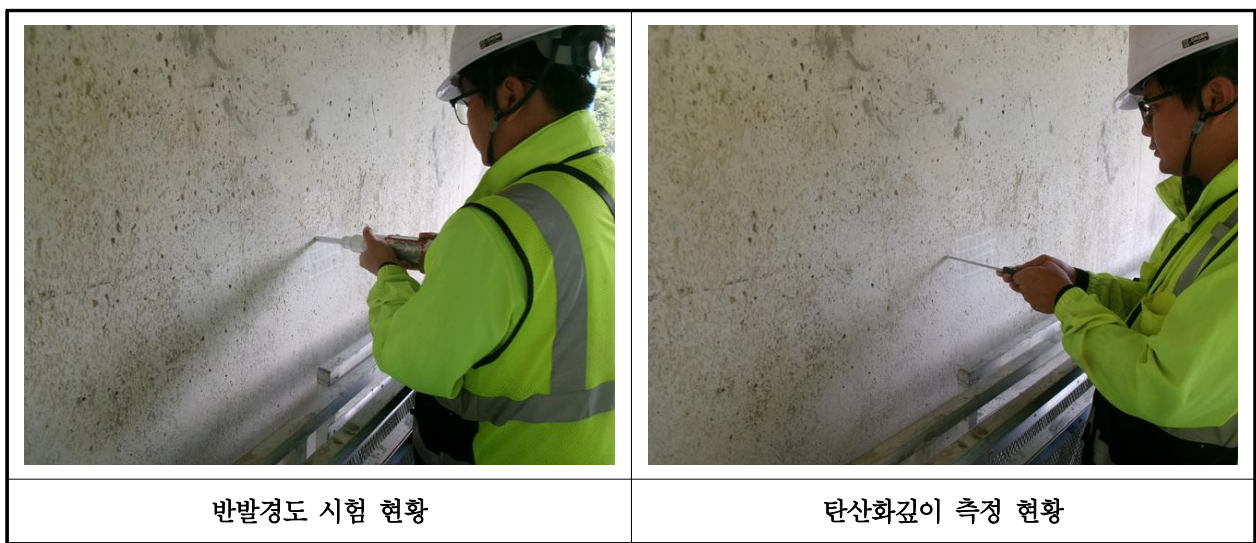
【사진 12.4.1】 콘크리트 내구성조사 현황
