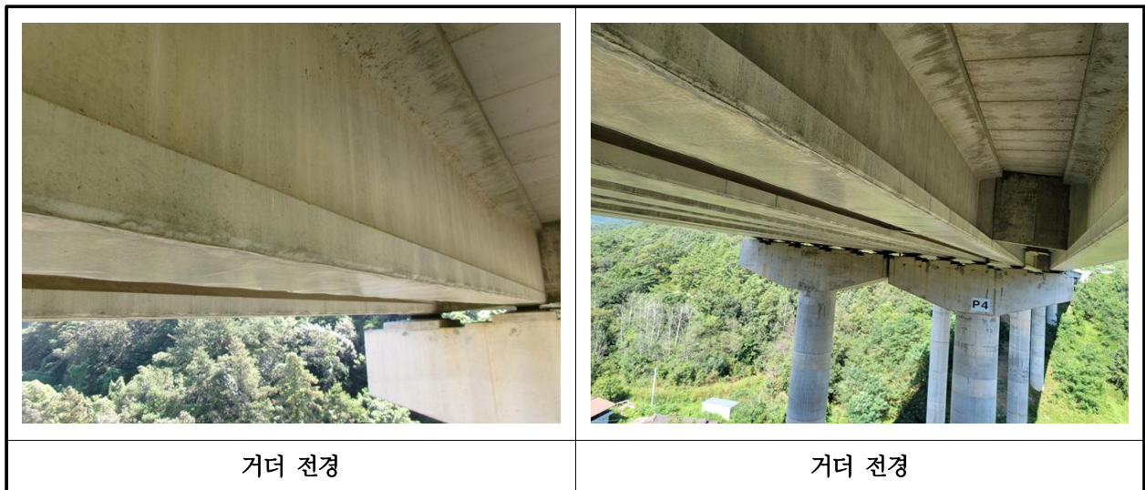
【사진 12.3.4】 거더 전경
