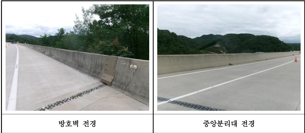
【사진 12.3.49】 방호벽 및 중앙분리대 전경
