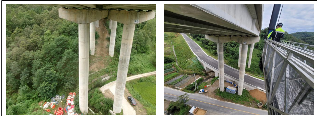
교각 코핑부 상태양호
