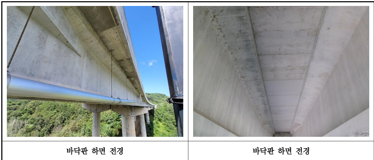
【사진 12.3.2】바닥판하면 전경
