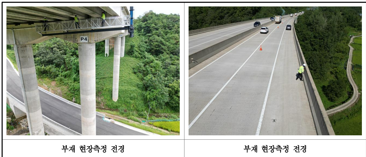
【사진 12.2.1】 부재 현장측정 전경
