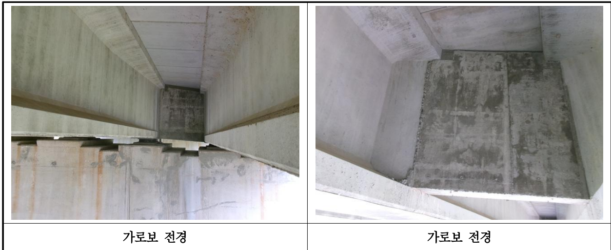
【사진 12.3.6】 가로보 전경
