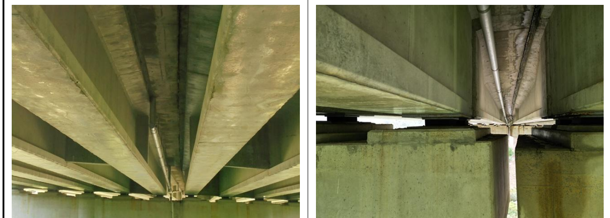
중분대 하면 상태양호
