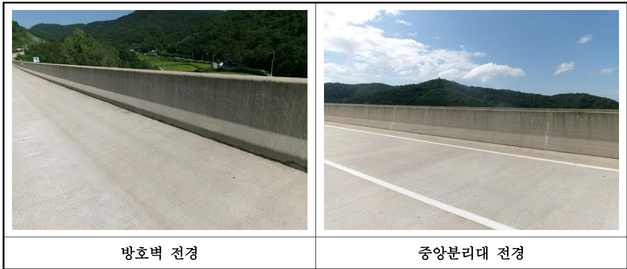
【사진 12.3.24】 방호벽 및 중앙분리대 전경
