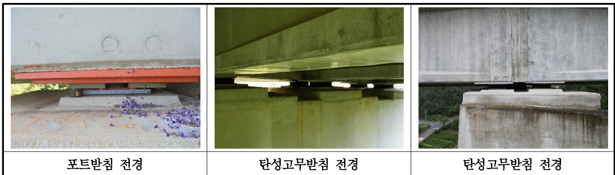
【사진 12.3.38】 교량받침 전경
