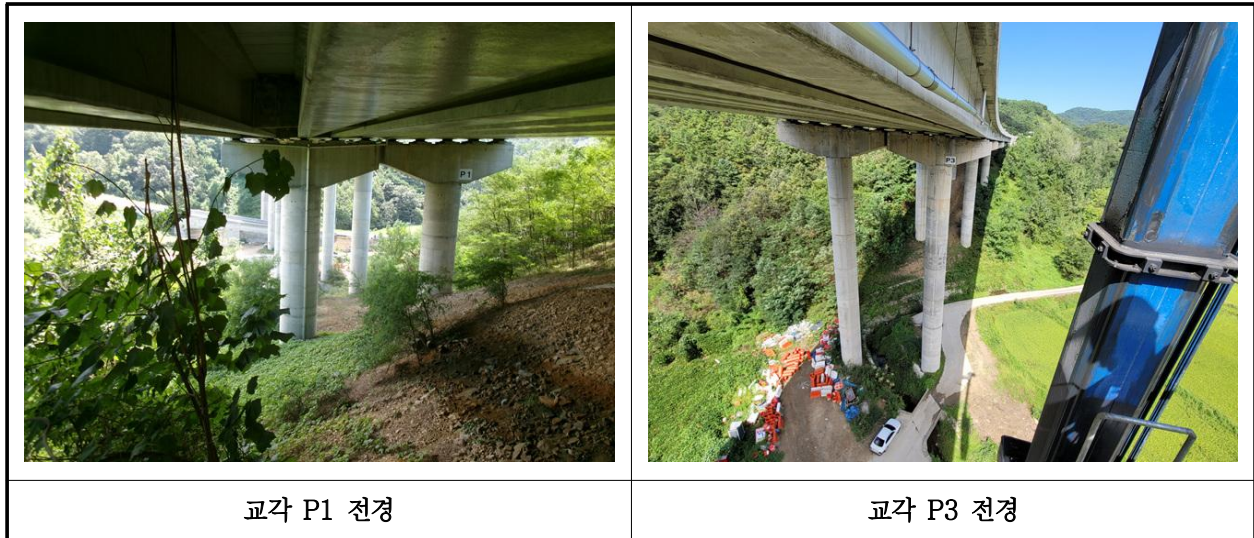
【사진 12.3.10】 교각 전경
