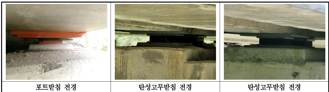
【사진 12.3.13】 교량받침 전경
