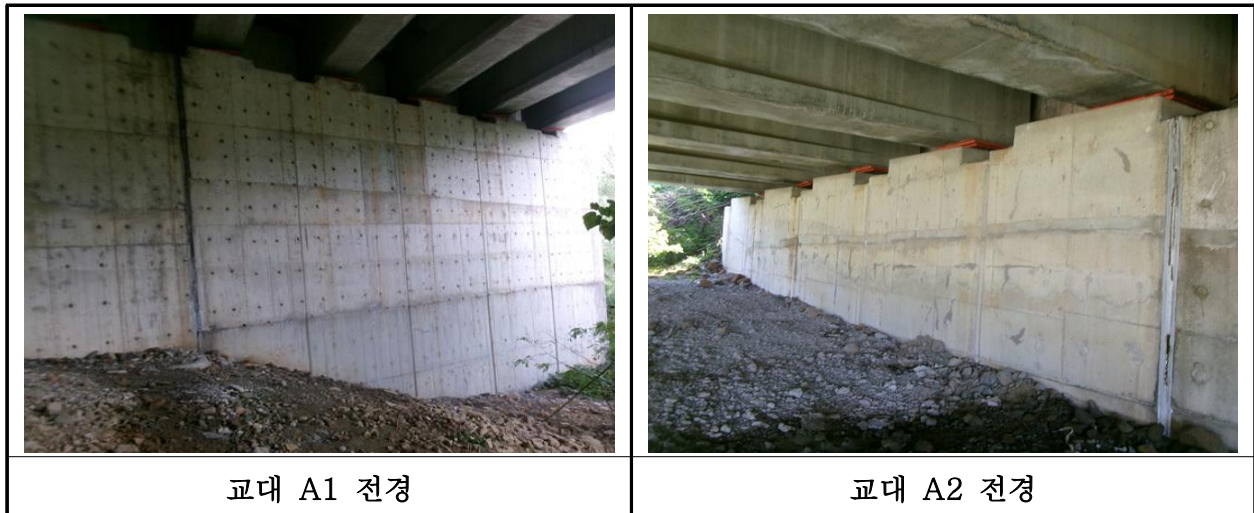
【사진 12.3.8】 교대 전경
